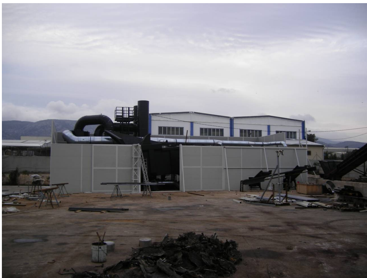
Φώτο 6.1: Κατασκευή ηχοπετάσματος περιμετρικά του σπαστήρα στη φάση εγκατάστασής του.
